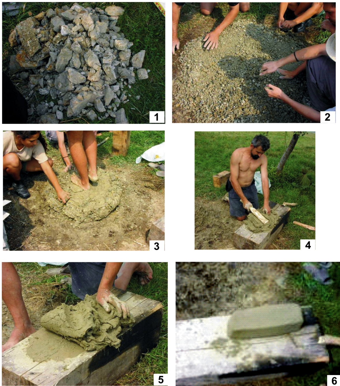
Fig. 116. Principalele etape ale prelucrării preliminare a lutului.
